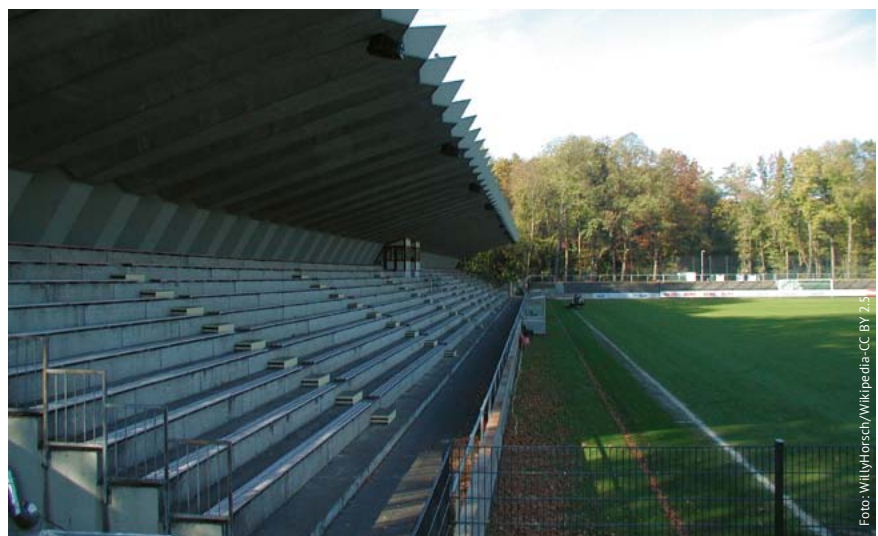
Herzstück des RheinEnergieSportpark – der Sportanlage des 1. FC Köln – ist das Franz-Kremer-Stadion.
